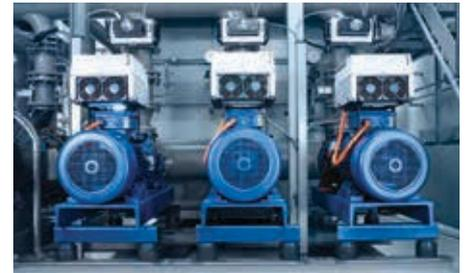
Die Etanorm-Pumpen sind jeweils mit der Drehzahlregelung PumpDrive ausgestattet.
