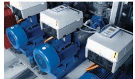
Jede der Pumpen ist für einen Förderstrom von 100 m³/h ausgelegt.
