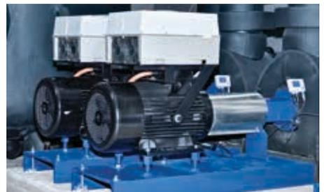
2 Etanorm PumpDrive-Pumpen als Dauerläufer mit hocheffizienten KSB SuPremE®-IE5-Motoren\*
