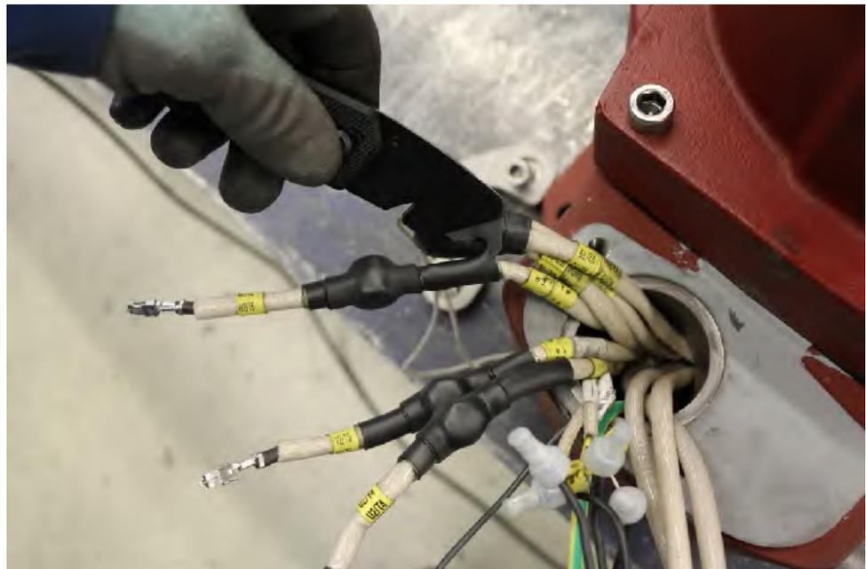
Abb. 46: Schrumpfschläuche aufschneiden
